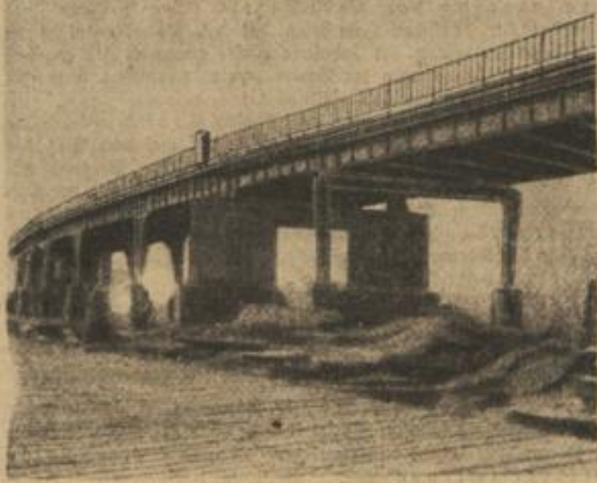
Die am 18. Dezember zur Eröffnung gelangende Siemens-Anschlußbahn führt vom Bahnhof „Jungfernheide“ über die Bahnhöfe „Bernwerf“, „Siemensstadt“ nach „Gartenfeld“. Das Bild zeigt die Stadtkreuzung zwischen Holzdammen und Siemensstadt; im Hintergrund der Bernwerf-Neubau.
