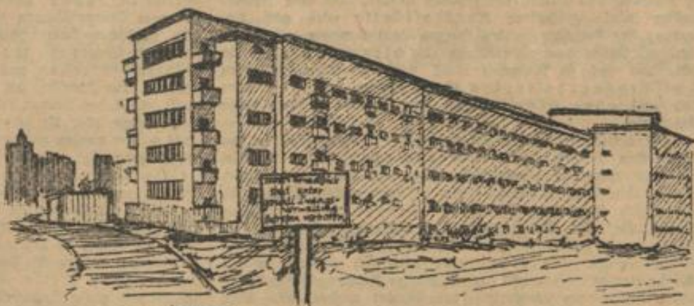
Niemand darf hinein. 500-600 Wohnungen harren der Fertigstellung.
