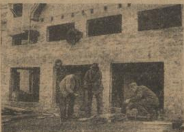
Freiwillige Rohrleger bei der Arbeit.
