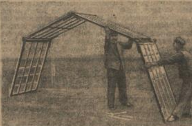
Gewächshausbau mit Hilfe von Frühbestfenstern durch Anwendung von Fensterverbindern.
