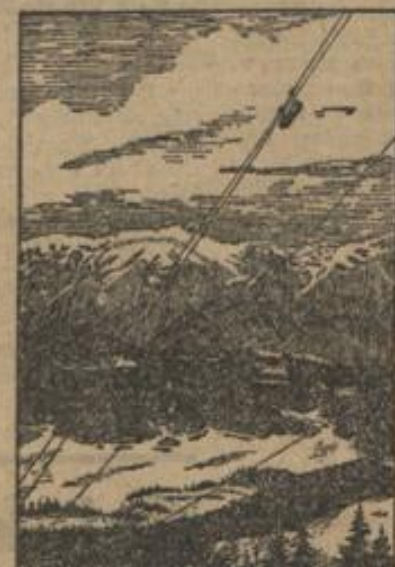
Hilfseilbahn zum Bau des Tunnels
