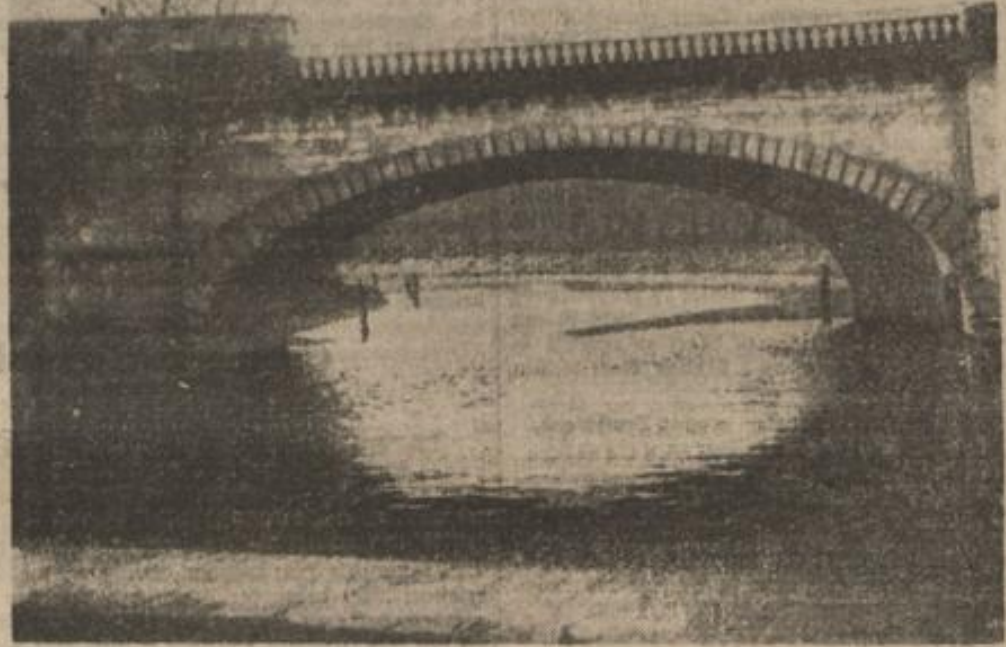
Die wenig beachtete Stadtbahnbrücke an der Tiergartenschleuse
