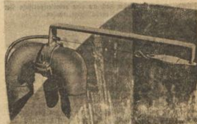
Schmelzsicherung über dem Brennstoffbehälter, welche durch ihr Schmelzen den Draht entspannt, der nun durch Lösen der Klinke des Minimax-Apparates drehen läßt und zur Betätigung bringt.
