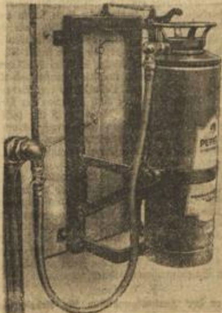
Automatischer Schaumlöschapparat für flüssige Brennstoffe.
