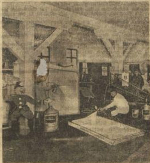
Feuerschutz-Imprägnierflüssigkeit wird mit Spritzapparaten, aber auch mit Glaskannen aufgesprengt.
