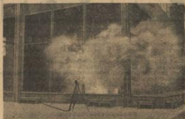
Brand eines alten Oelschalters
