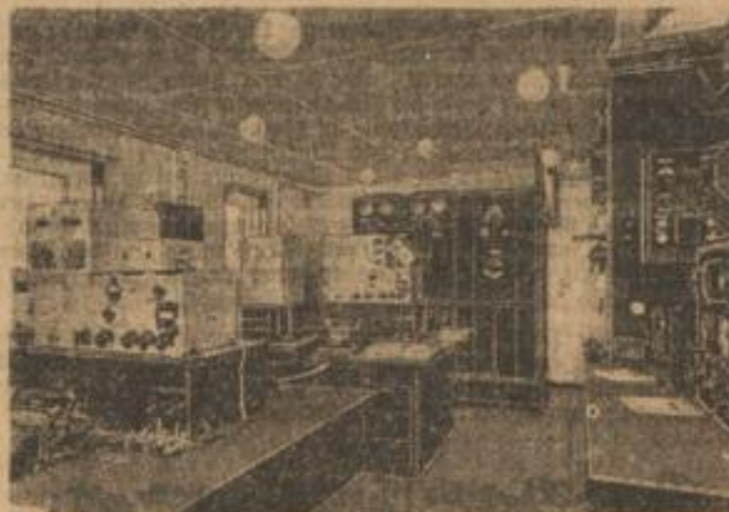
Hauptfunkhalle des Schnelldampfers „Europa“. Im Hintergrund Lanzwellensender, im Vordergrund Empfangsapparate.
