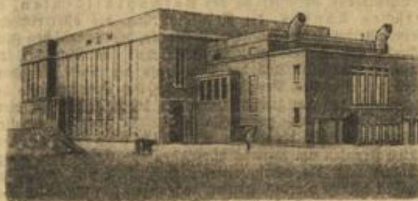
Das Spitzenkraftwerk des MEW in Hennigsdorf
