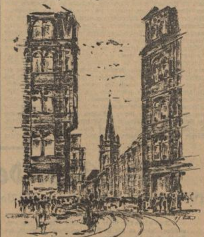
Der neue Durchbruch mit Blick auf die Jerusalemer Kirche.
