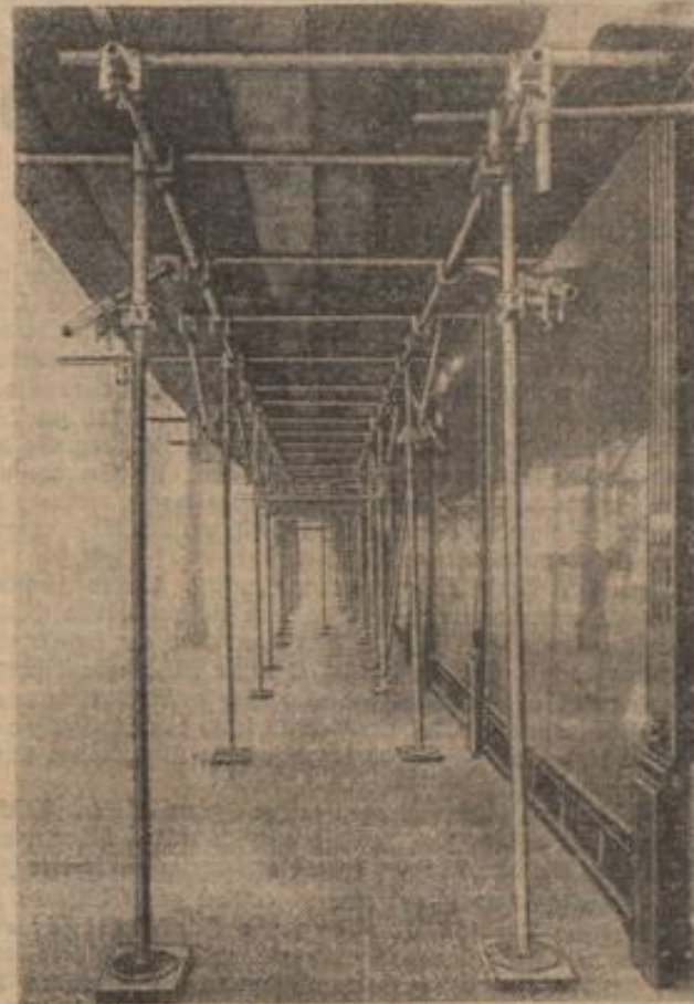
Leicht und sicher steht das Gerüst
