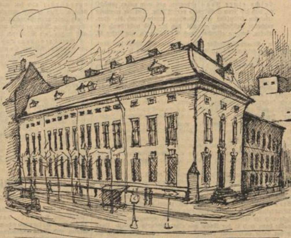
Das „Lagerhaus“ in der Klosterstraße vor dem Abruch.
