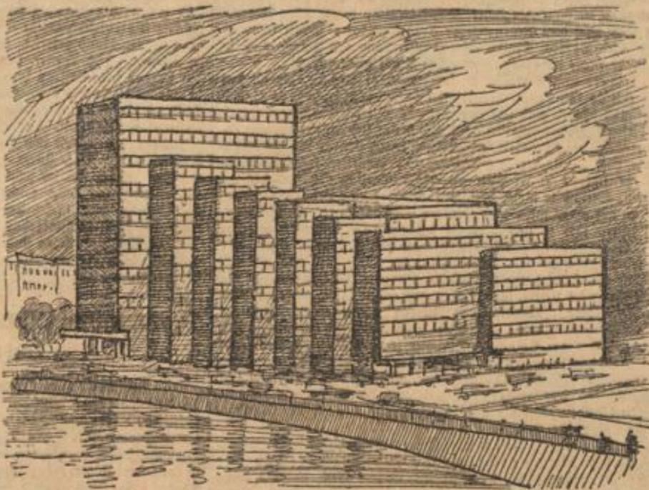
Der imposante Bau, der hoch über die benachbarten Tiergarten-Wohnvillen hinausragt, umschließt einen umbauten Raum von 83 000 cbm. Im Frühjahr 1930 wurde er begonnen; eine Materialbrücke beförderte mittels Großbagger und Transportband Kies und sonstiges Baumaterial direkt von den Lastkähnen am Landwehrkanal über die Straße zur Baustelle. Im Oktober 1931 soll der Riesenbau, dessen Entwurf von Prof. Fahrenkamp stammt, unter der Bauleitung des Ing. Dürr bezugsfertig sein.
