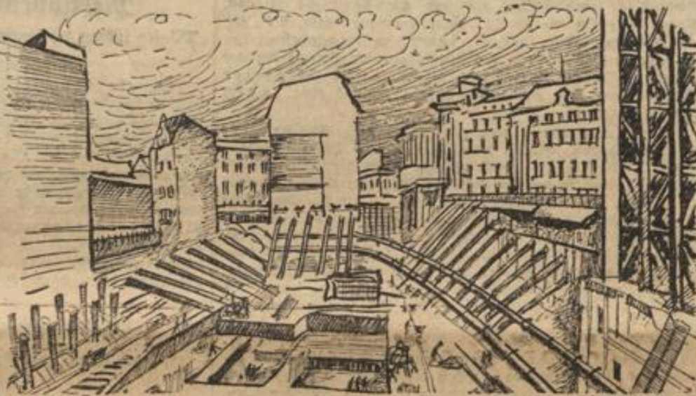
Die riesige Baugrube des „Columbus-Hauses“
