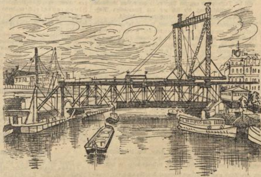
So sieht die Jannowitzbrücke im Augenblick aus.
