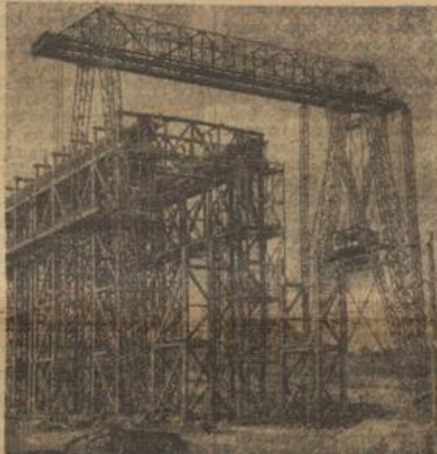
Das Schiffshebewerk bei Niederfinow im Bau
