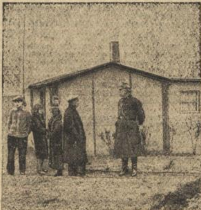
Das Häuschen in der Laubenkolonie „Felsenecke“, in dem der erschossene Arbeiter Klemke wohnte.
