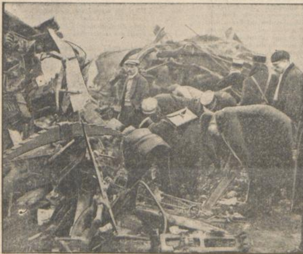
Aufräumungsarbeiten an der Trümmerstätte bei Lagny, 20 Kilometer von Paris
