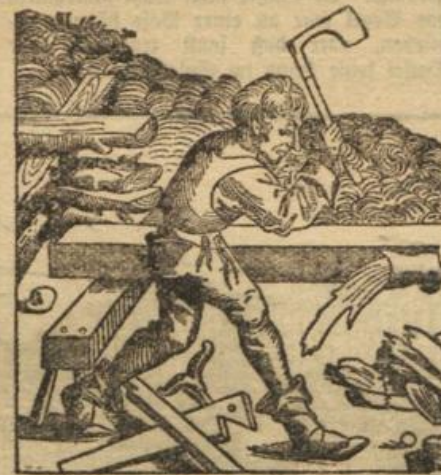
Zimmermann bei der Arbeit Holzschnitt von R. Wohlgemuth. (1409).
