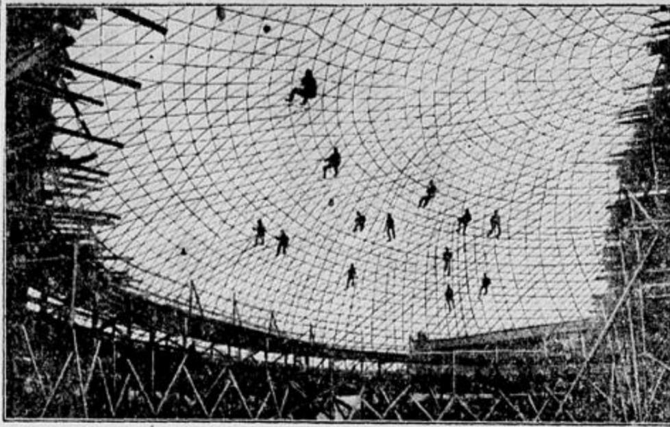
Die Dyckerhoff u. Widmann A. G. hat ein System erfunden, das ermöglicht, Kuppeln nach dem sogenannten Spritz-Betonverfahren zu betonieren. Es wird zunächst das Gerippe der Kuppel aus Stahlstäben hergestellt und dann durch Anwendung von Druckluft allmählich das Feiß-Gerippe einbetoniert. Unser Bild zeigt die Arbeiter am Kuppelgerüst, wie in einem Spinnennetz gefangen.
