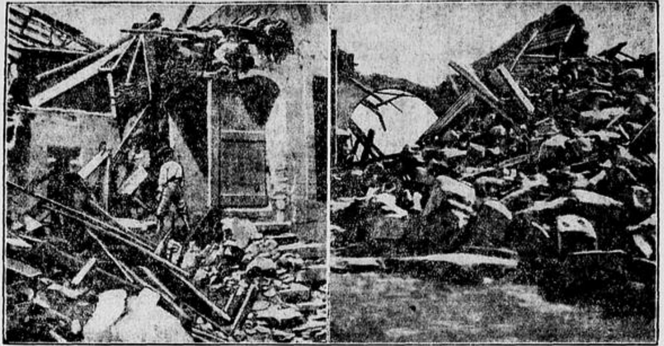
Die Ruinen eingestürzter Häuser in Melfi.
