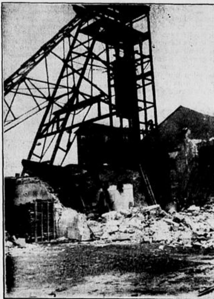
Der zerstörte Förderturm
