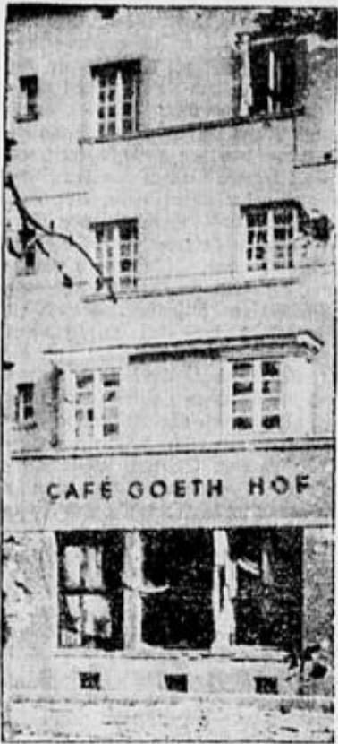
Der zerstörte Goethehof
