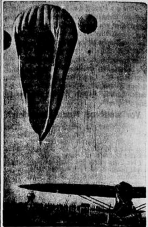
Der Stratosphärenballon „NEM“, dessen Hülle auf dem Prater-Flugfeld bei Moskau bei der Füllung zu einem neuen Stratosphärenflug durch eine Explosion vernichtet wurde. Die Gondel und die danebenstehende Besatzung blieben unverletzt. Der Ballon hatte vor einem Jahre mit einem Flug von 17.000 Metern einen Höhenweltrekord aufgestellt, der später durch einen anderen russischen Ballon überboten wurde.
