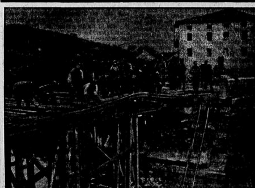
Von den Kämpfen bei Irun Pioniere der farbigen Armee versuchen eine gesprengte Brücke wiederherzustellen.
