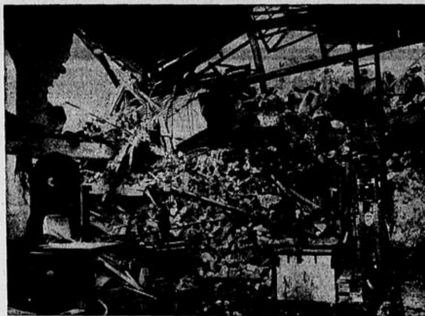
Herabstürzende Felsmassen zerstörten ein Eisenbahngebäude
