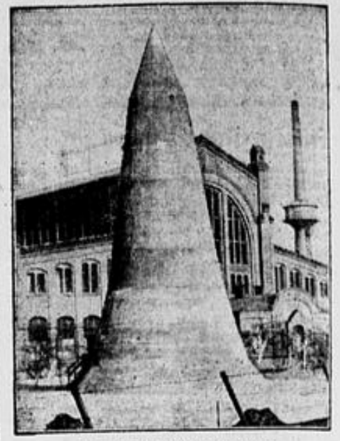
Der erste Luftschutzturm
