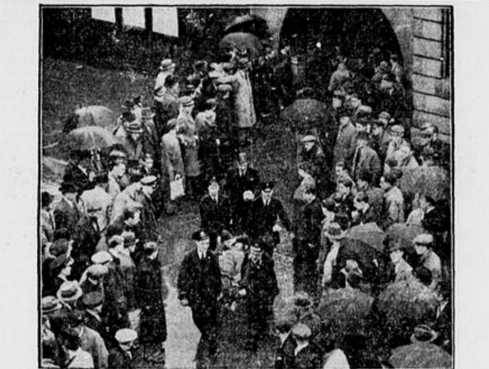
Das schwere Unglück auf der Londoner U-Bahn. Auf dem Bild sieht man, wie Verletzte von den Vergungsmannschaften durch das dichte Spalier der Menge aus dem Bahnloch herausgehoben werden.
