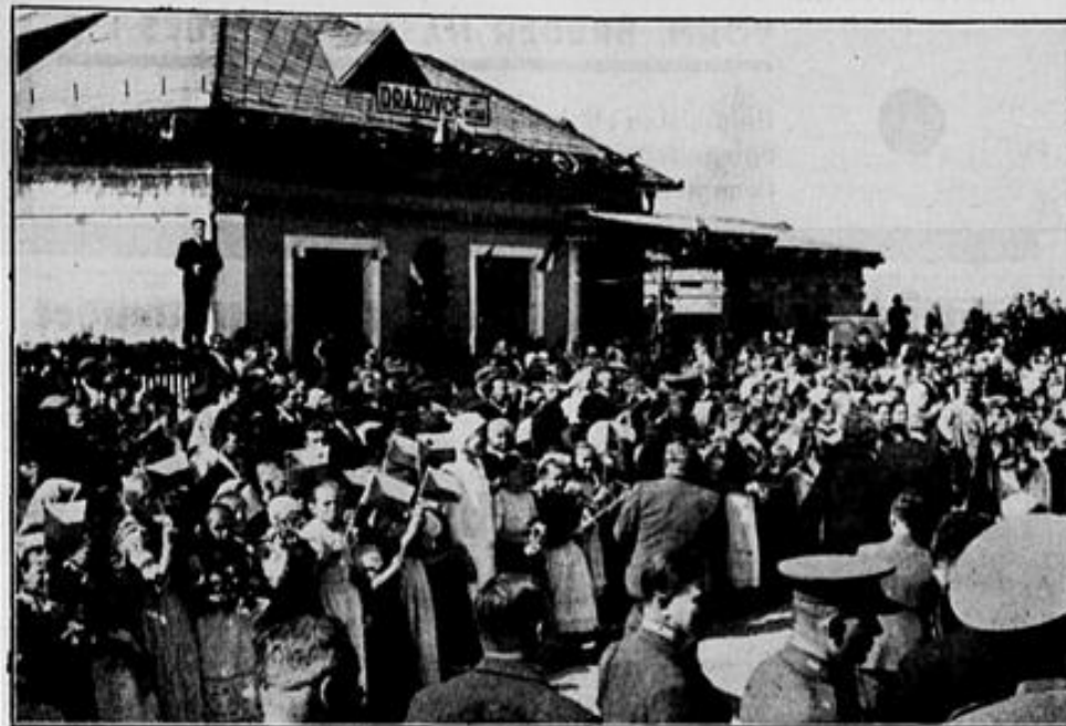
Eröffnung der Bahn Zbehy-Zlaté Moravce in der Station Dražovice
