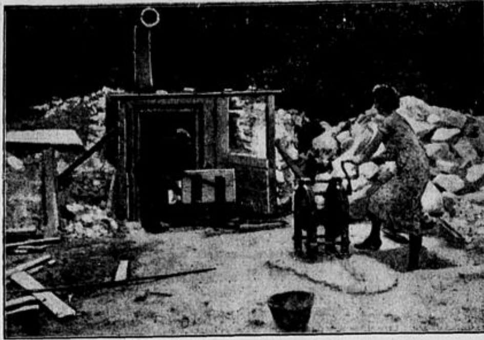
Luftschutzraum im Bergesinnern
