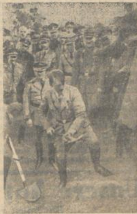
Er tut den ersten Spatenstich
