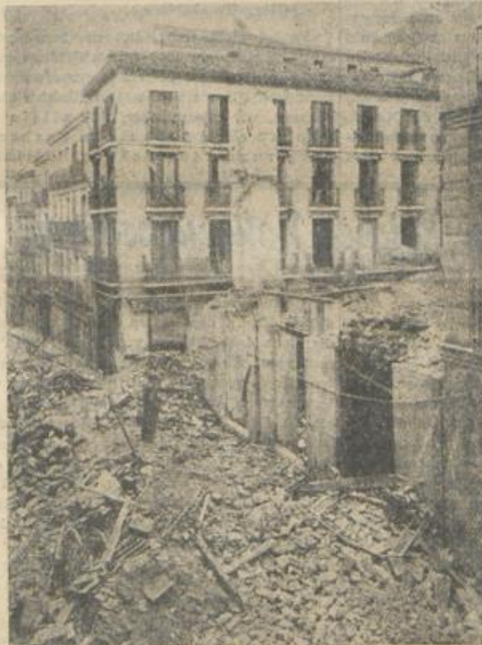
Wirkung einer Bombe
