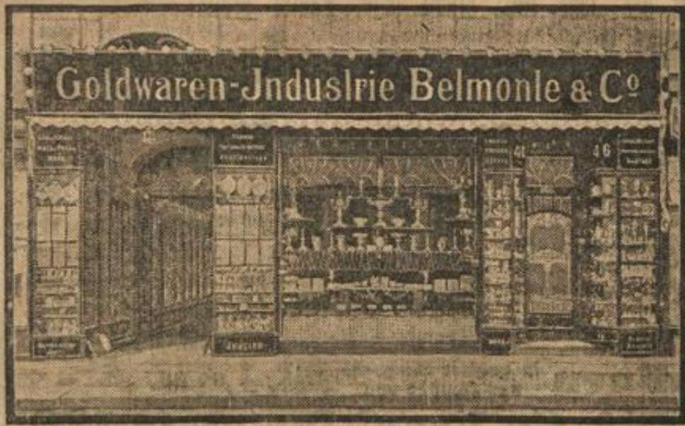
Ansicht von der Strasse.
