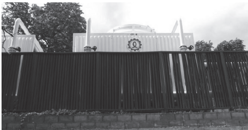
เครื่องปรับอากาศใหม่ใช้ระบบระบายความร้อนด้วยน้ำ
