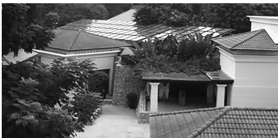
แผงโซลาร์สำหรับทำน้ำร้อนเพื่อใช้ในรีสอร์ท ทดแทนการใช้พลังงานไฟฟ้าและแก๊ส
