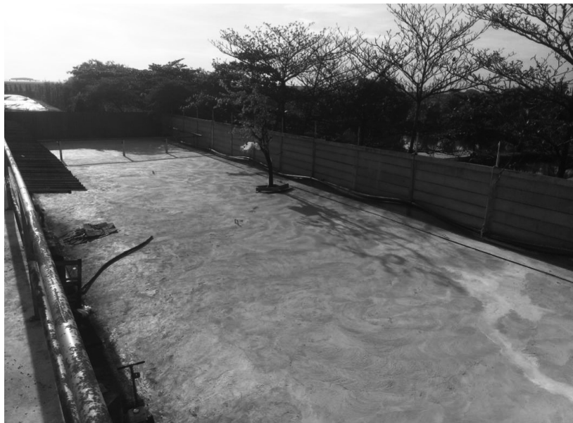
พื้นที่ด้านข้างโรงงานที่เทปูนใหม่ เพื่อป้องกันไม่ให้น้ำเสียไหลเข้า พื้นที่ของชาวบ้านที่อยู่ติดโรงงาน
