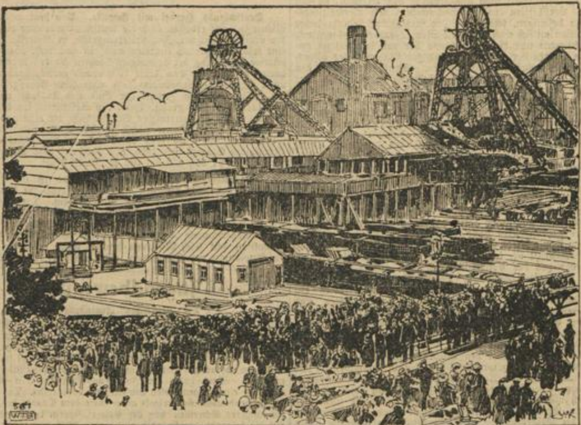
Die Grubenkatastrophe in Cardiff. Die Unlücksstätte
