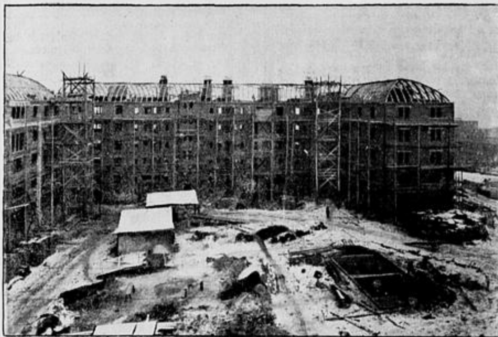
Wohnhausblock in Aussig a. E.
