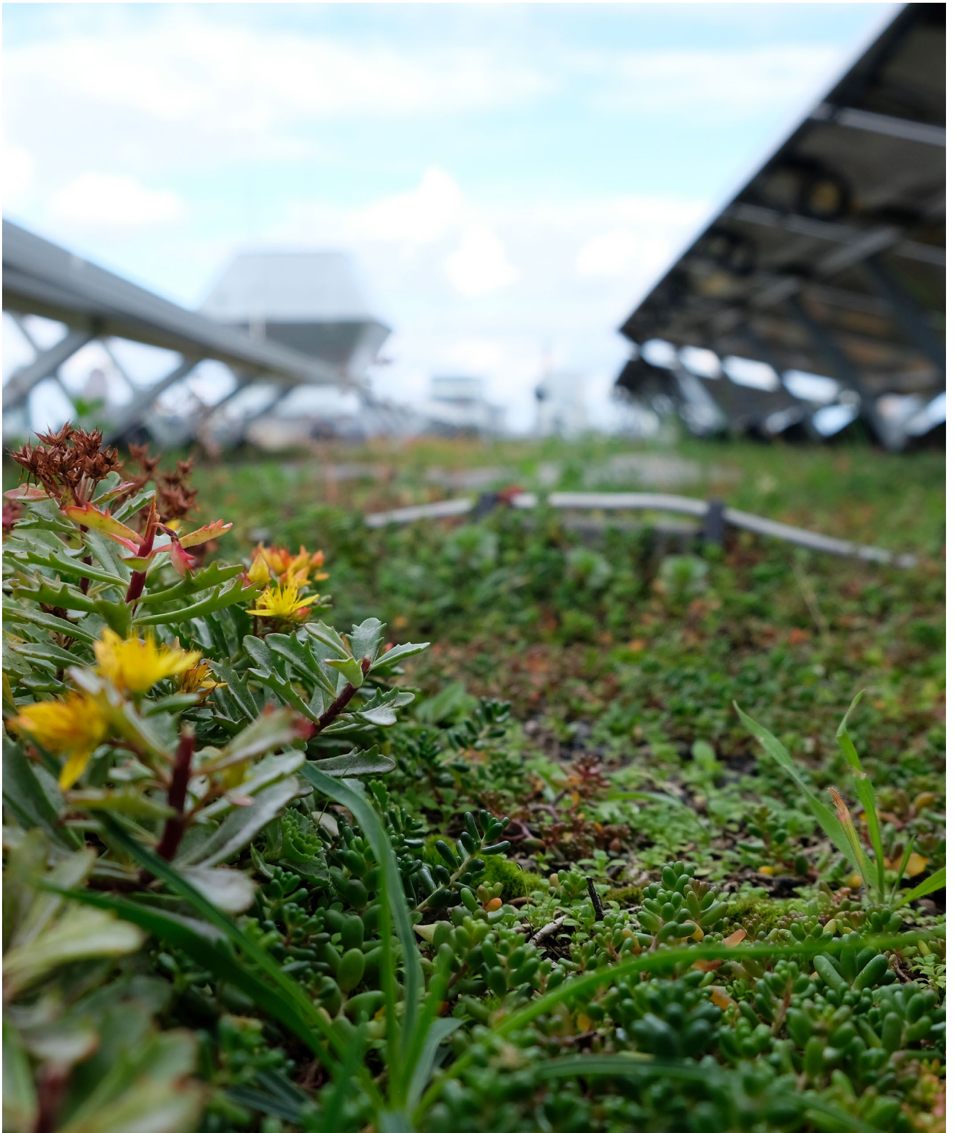
Die Solaranlagen auf den Dächern der Friedrich-Ebert-Stiftung in Berlin produzieren jährlich rund 92.000 kWh Strom, decken etwa 8 Prozent des Energiebedarfs und sparen 54 Tonnen CO 2 ein. Das nachhaltige Projekt verbindet Photovoltaik mit Dachbegrünung.
