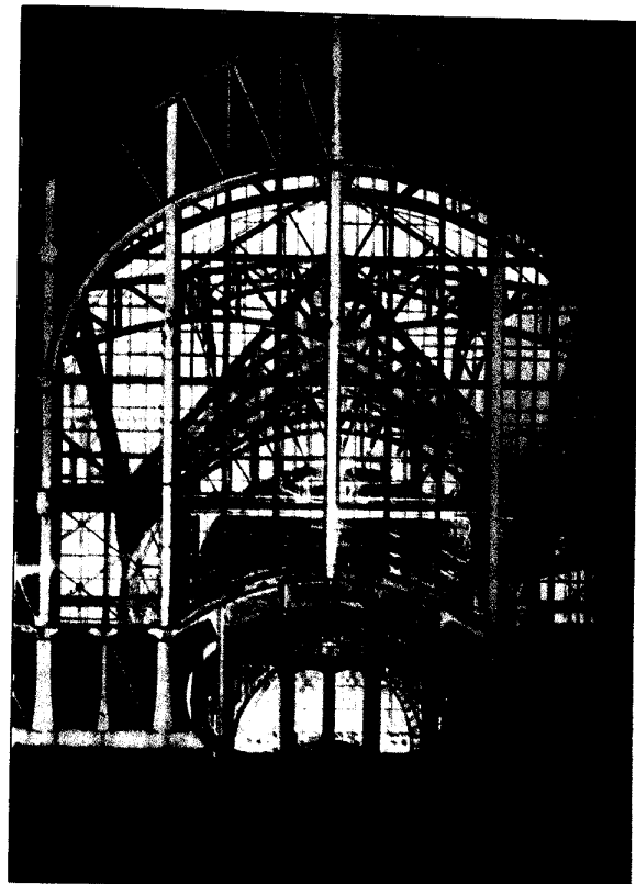
Dortmund: hala mașinilor de la mina Zollern 2/4
